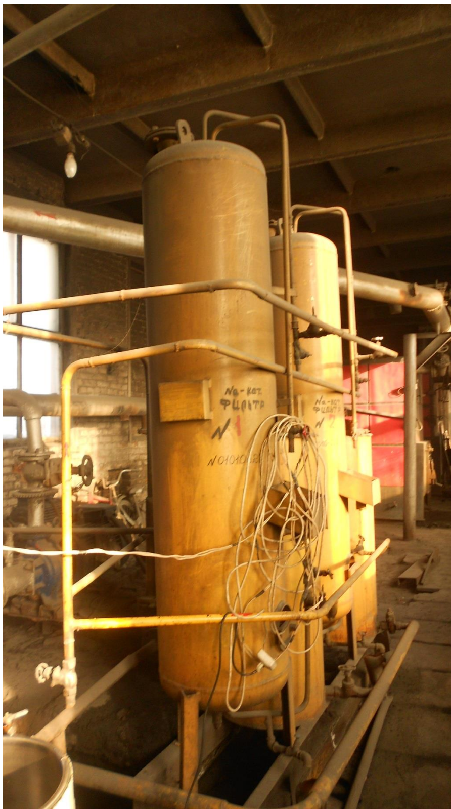
Рис 5 Внешний вид ХВП, установленной в котельной №1
