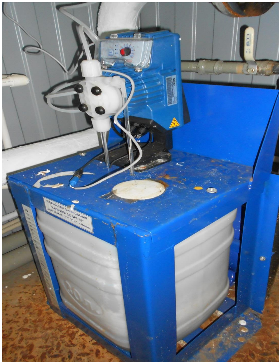
Рис 13 Внешний вид установки дозирования жидких химреагентов
