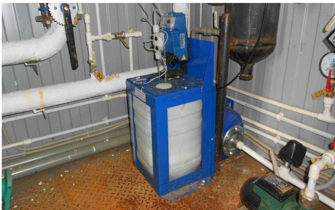
Рис 9 Внешний вид установки дозирования жидких химреагентов
