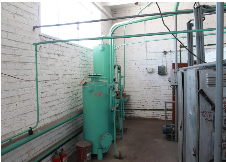
Рис 15 Внешний вид ХВП, установленной в котельной №3
