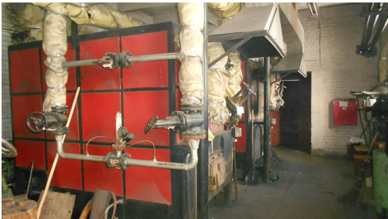
Рис 7 Твердотопливные котлы, расположенные в котельной с. Люм
