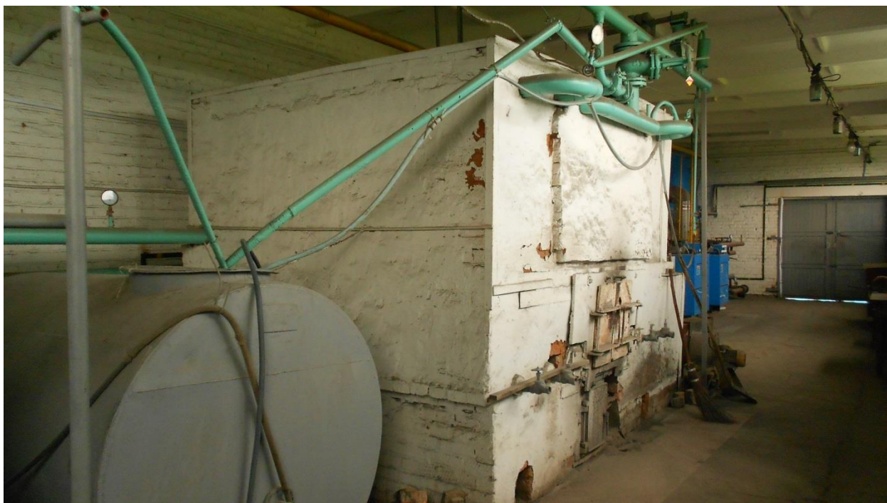
Рис 14 Внешний вид твердотопливного котла КВс - 0,5Т котельной № 3
